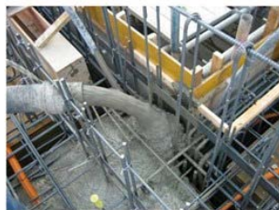
打設状況(再生コンクリートM)
