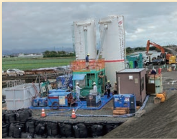
プラント設置状況
