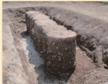
改良体出来形
