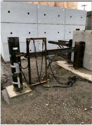
杭の水平載荷試験
