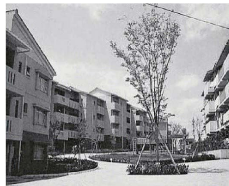
写真 3-1-1 前橋市清里前原団地
