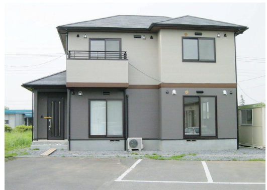
写真2 異なる換気システムを組み込んだ多数室からなる実験棟
