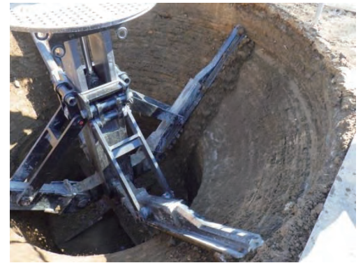
MBバケットによる掘削状況
