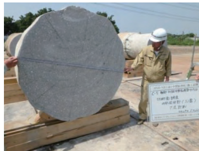
拡径部の断面寸法計測
