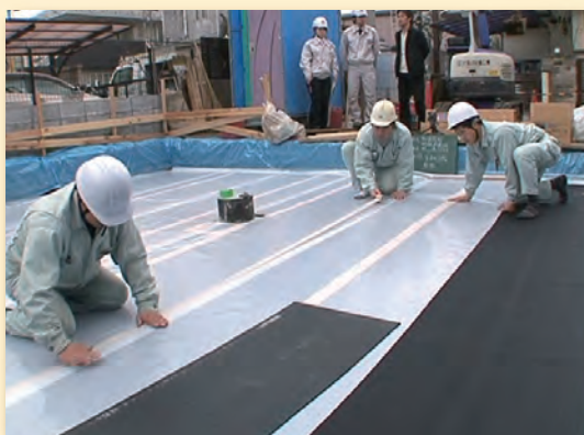
すべり材施工状況
