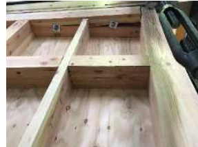
写真1 上枠の割裂
