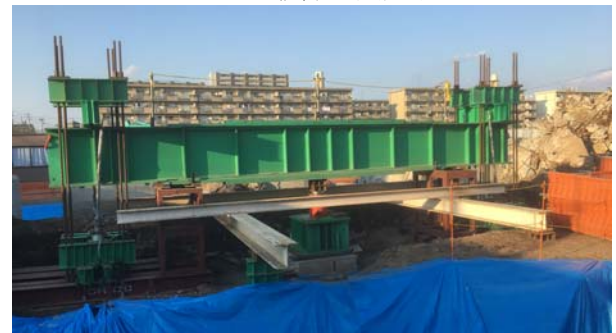
写真1 載荷試験(載荷梁)の状況
