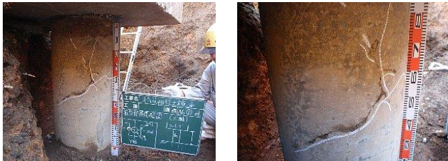
a) 全景 b) 詳細 写真 2 既存杭の損傷状況 (杭 No.2)
