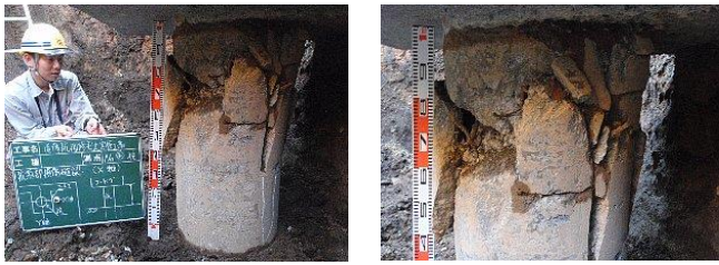
a) 全景 b) 詳細 写真 1 既存杭の損傷状況 (杭 No.1)
