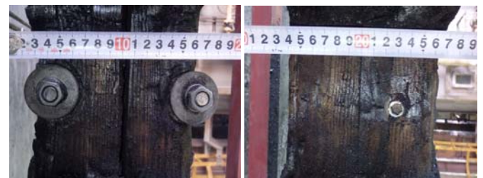
写真-1 試験後の接合具の様子 (試験体 B・炭化層除去後)
