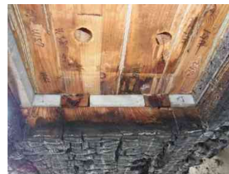
写真 2 接合部 梁底側 木造柱荷重支持部の状況
