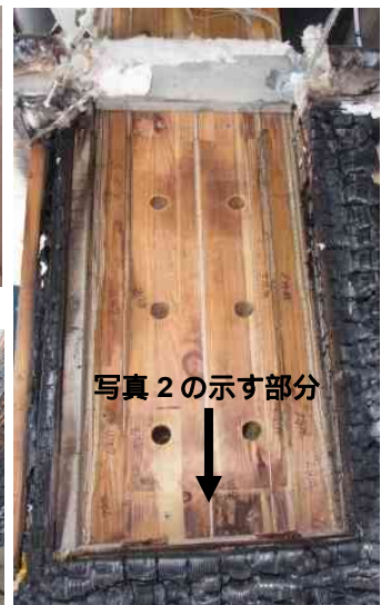
写真 3 木造柱荷重支持部 全体の状況
