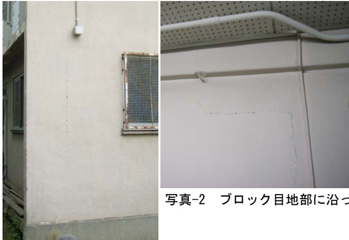
写真-1 CB 壁のせん断ひび割れ
