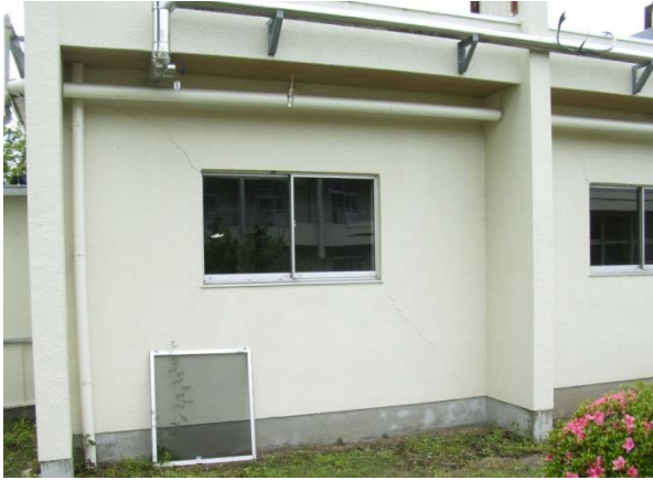
写真-1 CB 壁のせん断ひび割れ
