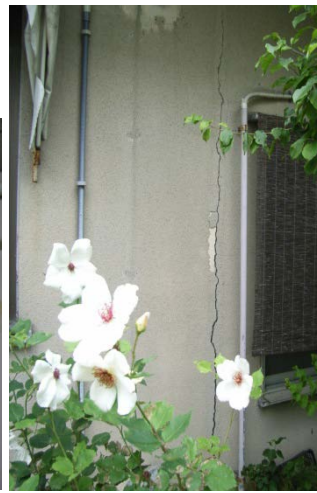
写真-2 ブロック目地部に沿ったひび割れ
