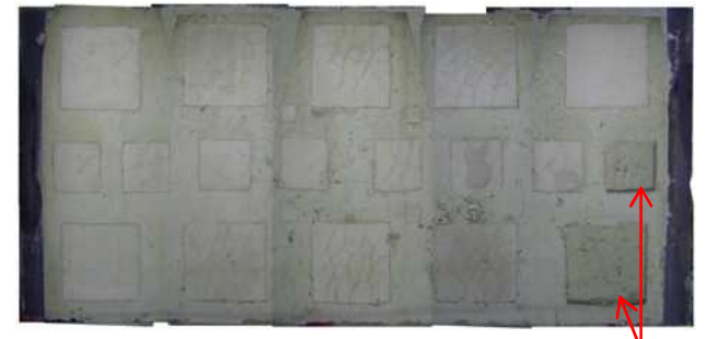
写真2 No.2(パッチ補修)実験後の状況
