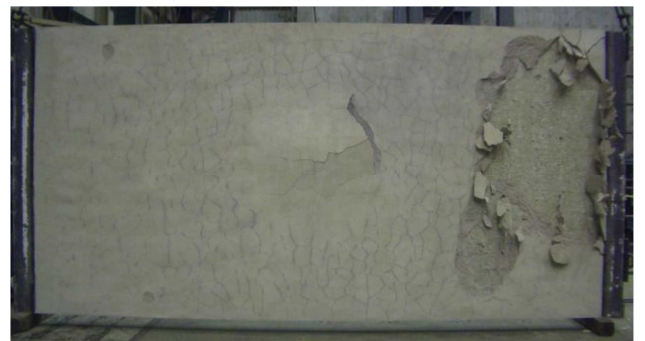
写真3 No.6(PCM20mm, ワイヤー)実験後の状況
