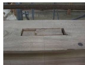
写真 3 柱頭ほぞせん断破壊
