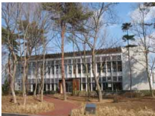
写真1 対象建物外観
