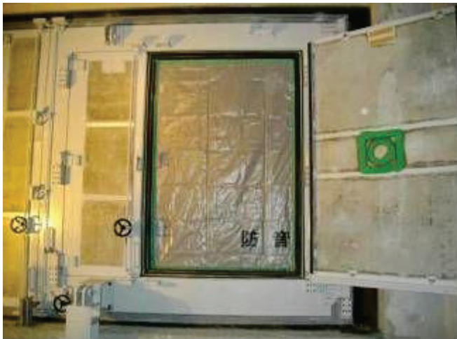
写真2 遮音シートの設置状況
