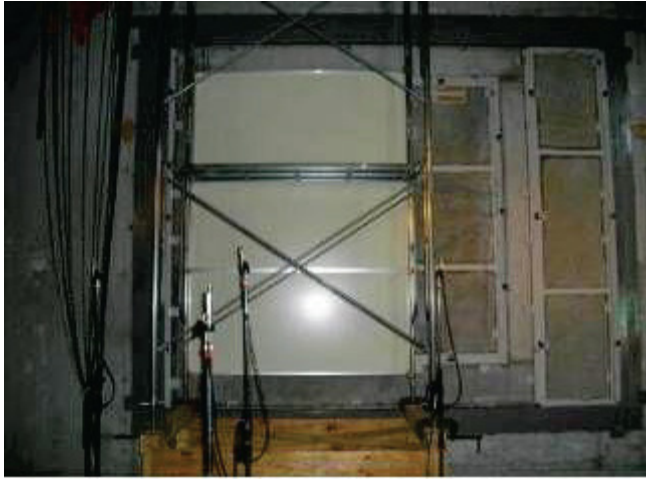
写真1 遮音パネルの設置状況
