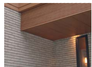
写真-2 【玄関ポーチ】
