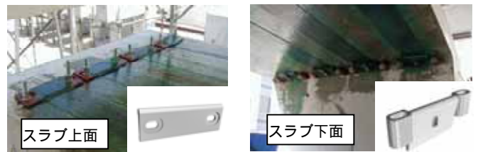
写真-1 CFシートのコンクリートへの定着 住宅の積載荷重 w = 1.8\text{kN/m}^2
