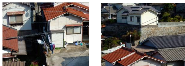
写真4 擁壁と住宅が近接して建つ宅地の一例 (広島県呉市)
