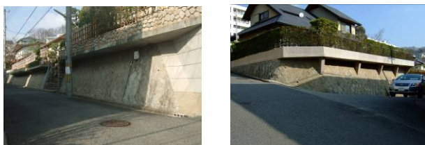
写真2 張出し擁壁の一例 (兵庫県神戸市)
