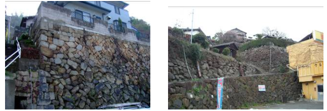
写真1 現存する空石積み擁壁の一例 (左：広島県呉市／右：長崎県佐世保市)
