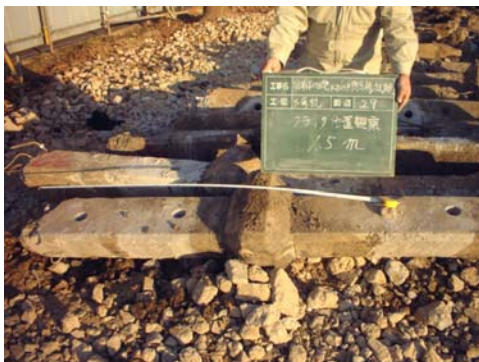
写真1 三角節杭の目視検査
