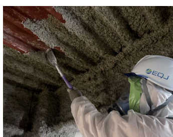
5. 石綿除去作業
