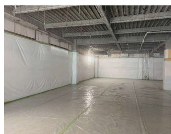
1. 隔離養生状況
