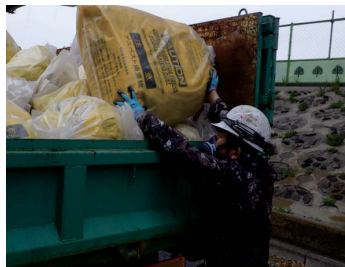
8. 廃石綿積み込み作業
