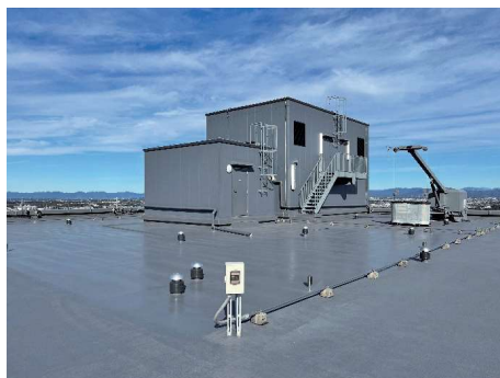
タワーマンション屋上
