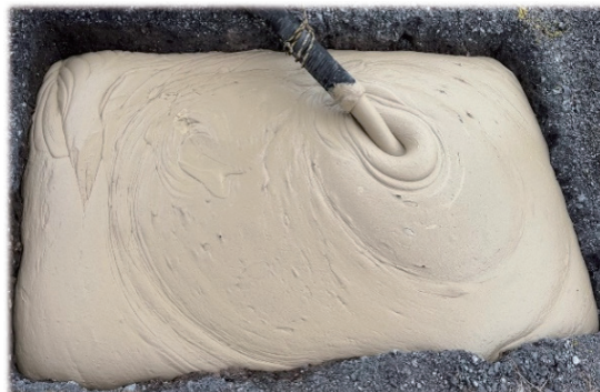
④気泡混合軽量土打設状況
