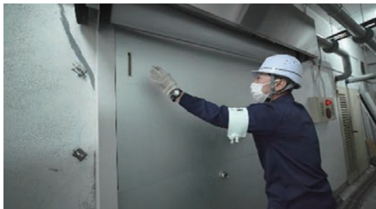
1. 固定枠内ボード設置
