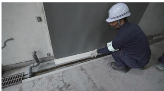
3. 止水シート押え・床用設置
