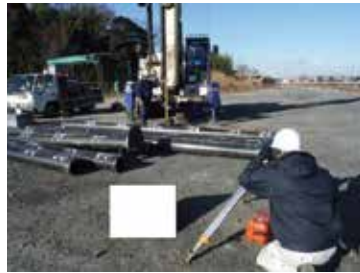
8. 杭の打ち止め確認
