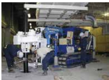
高さ 2.1m の超短尺施工機械
