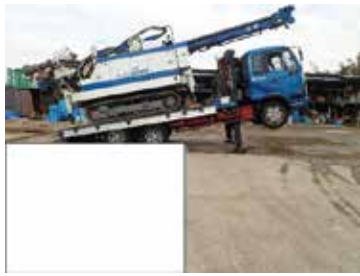
1. 施工機械搬入
