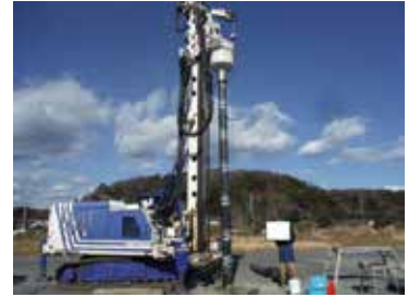
6. 杭の回転埋設
