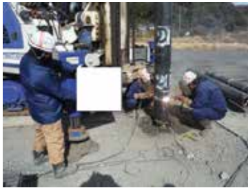
7. 杭の接続 (溶接継手)
