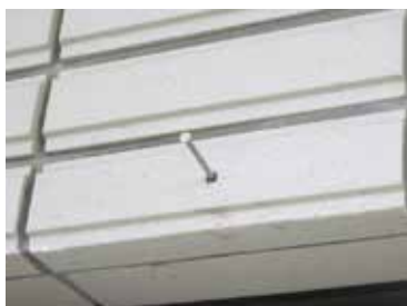
⑦ GNS アンカー R ピン挿入
