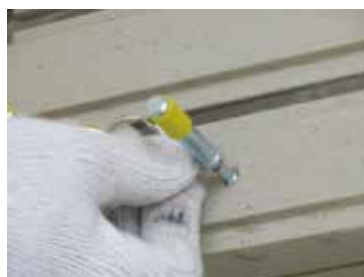
⑤穿孔深さと座掘り深さ確認
