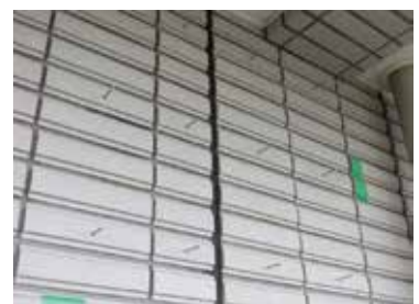
⑥ GNS アンカー R 挿入
