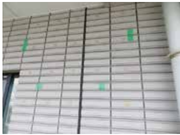
①アンカー位置墨出し
