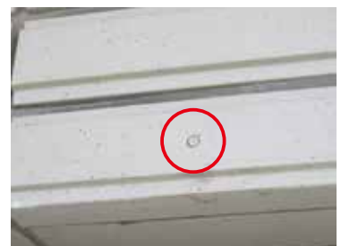
⑨施工完了
