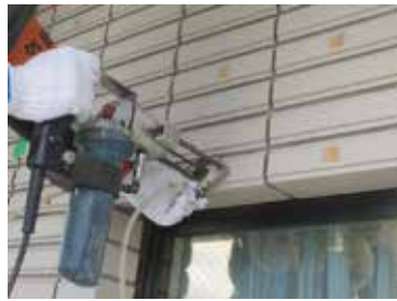
②無振動ドリルで穿孔
