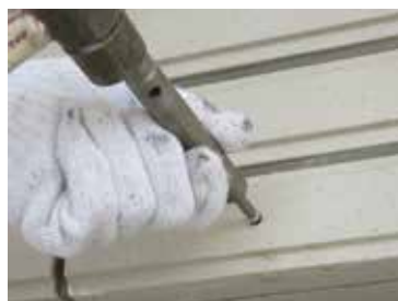
⑧専用打込み棒で打込み
