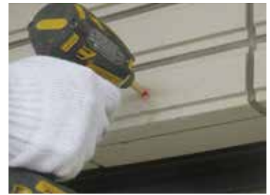
③座掘り作業
