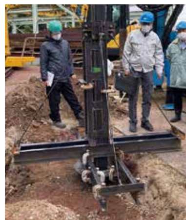
鋼製柱 建込み
