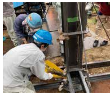
コンクリート 充填
