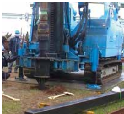
鋼管杭 打設時
