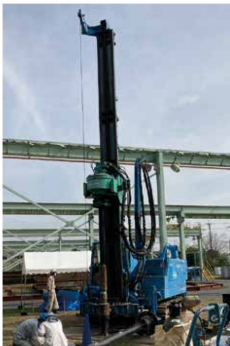
鋼管杭 打設前
