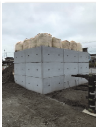
実物大の背面盛土施工試験
