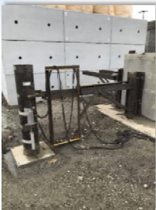
杭の水平載荷試験
