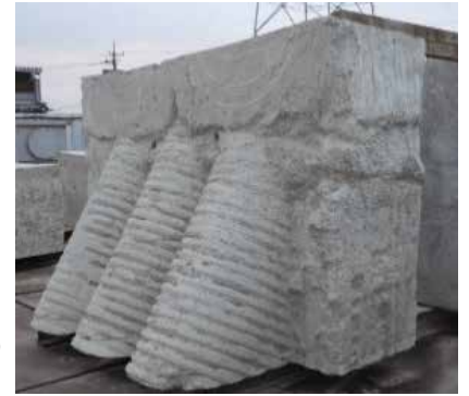
拡翼部の上部
