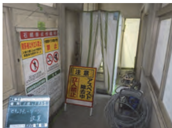
セキュリティゾーン設置
