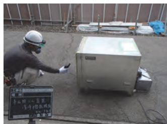
負圧除じん装置清浄機能検査
