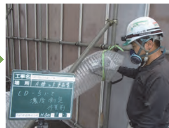
石綿粉じん濃度測定（作業前）
