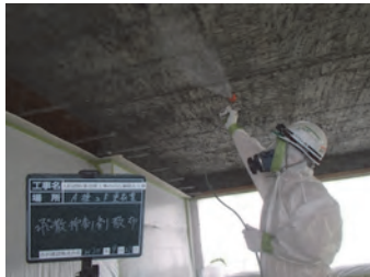
粉じん飛散抑制剤散布
