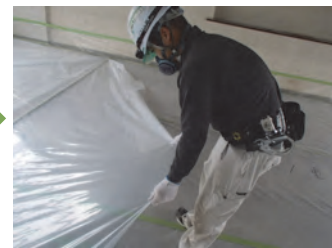
隔離養生作業
