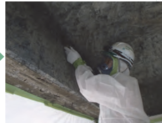
石綿除去作業
