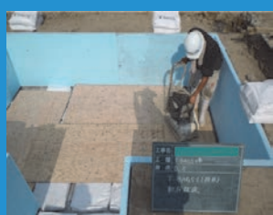
④基礎部転圧
