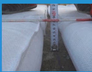
⑤基礎部高さ測定
