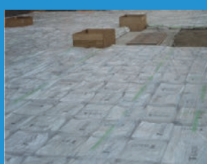
⑪土間部完成
