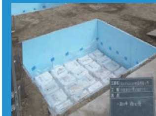
⑥基礎部完了
