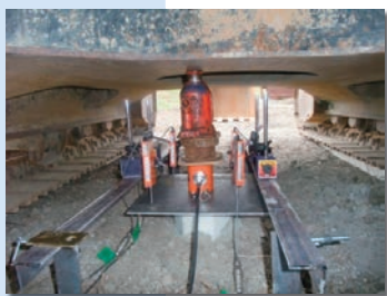
簡易載荷試験状況
