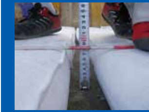
⑤基礎部高さ測定
