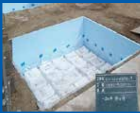
⑥基礎部完了
