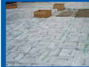
⑪土間部完成
