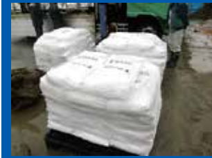
②材料荷卸し
