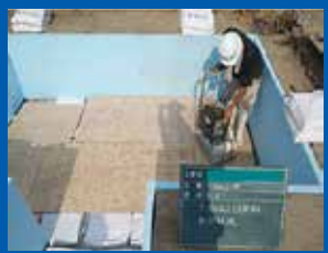
④基礎部転圧
