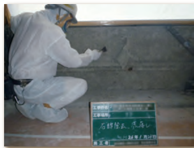
5. 除去作業状況
