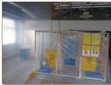
2. セキュリティゾーン設置状況
