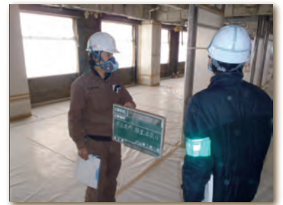
3. 隔離養生検査状況
