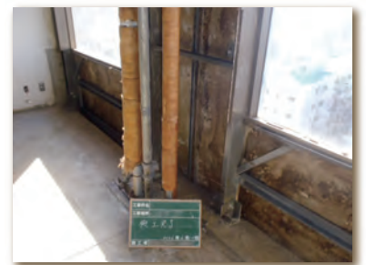
6. 除去作業完了
