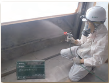
4. 飛散抑制剤散布状況
