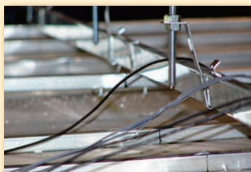
天井破壊：クリップ外れ
