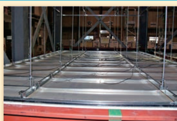
被害なし：クリップ外れなし
