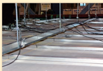
天井破壊：クリップ外れ
