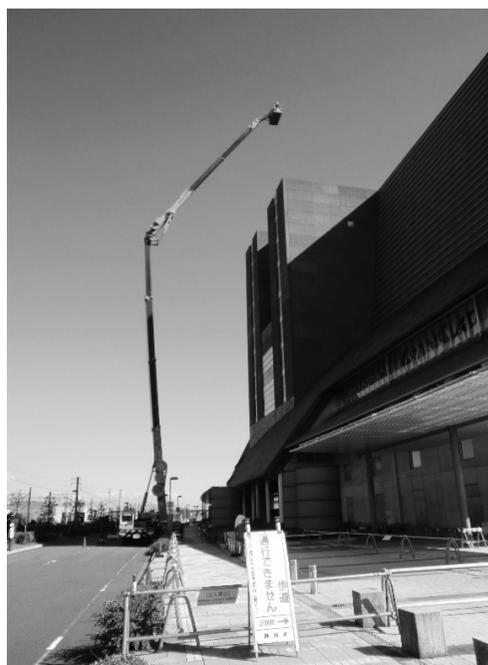
写真2 高所作業車による調査状況
