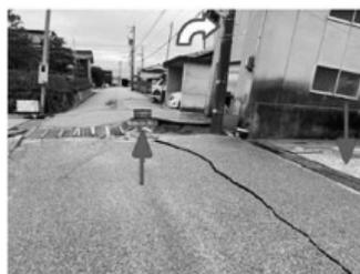
図2 浮き上がった地下埋設物と傾斜した建物
