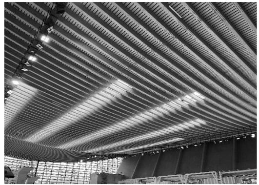
湾曲した大断面集成材による屋根架構
