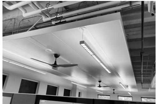
写真5 冷暖房用の天井放射パネル
