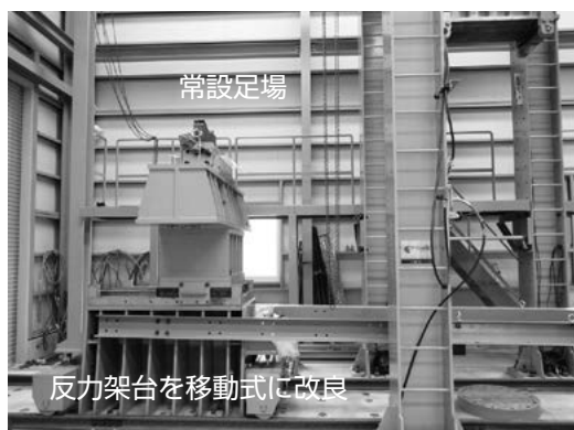
写真 6 杭強度試験棟（改良後）拡大
