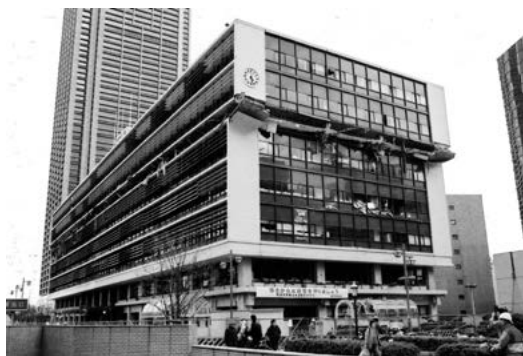
中間層破壊した神戸市庁舎（1995年）
