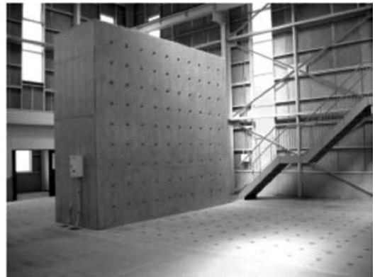
写真2 構造・材料試験棟の反力床・反力壁
