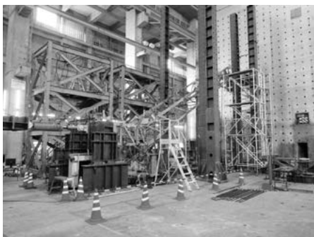
写真 15 エスカレータトラスの実大試験
