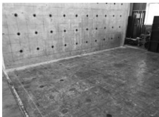
写真3 反力床・壁の墨出し状況
