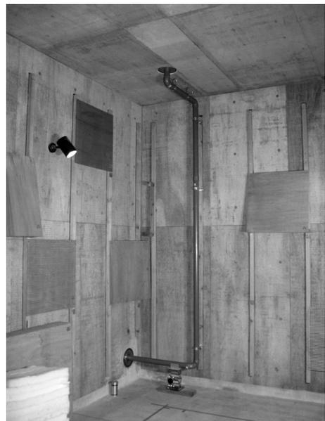
写真3 1階室内に設置した配管(VP50を使用)
