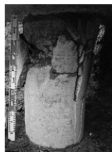
図 1 損傷杭
