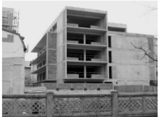
写真6 建設中の建物。壁式構造の様だが、かなり大胆な壁配置。茶色の部分は大型のレンガブロックを積んだもの。このブロック、現地では普通に使われているもので結構重量がある。
