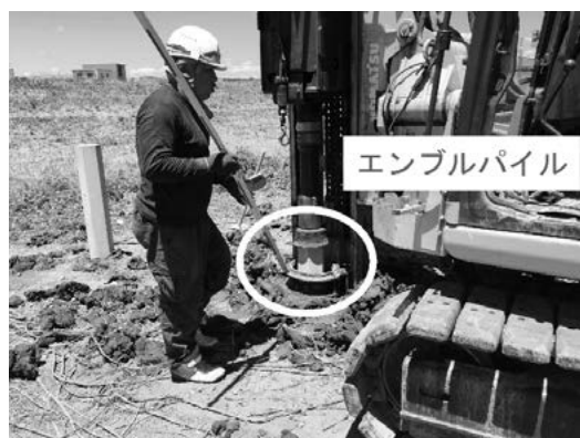
写真2 エンブルパイルの施工状況
