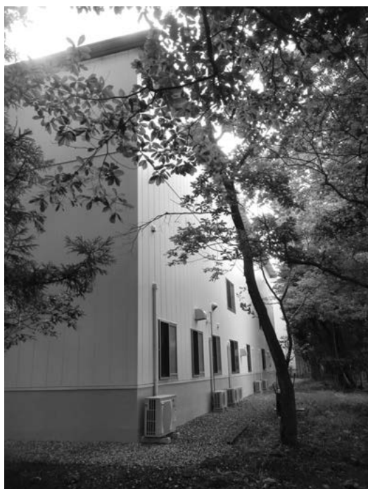
写真3 北側雨水浸透システム（碎石浸透）
