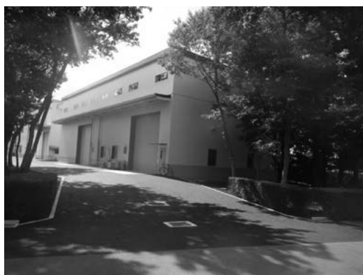
写真 2 竣工後の状況（夏）
