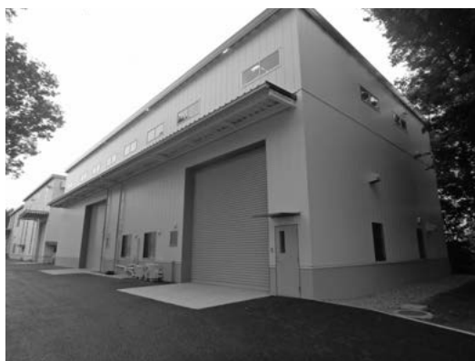
図7 試験棟外観（東側：試験体製作ヤード側より）
