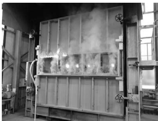
写真1 発炎時の非加熱面の状況
