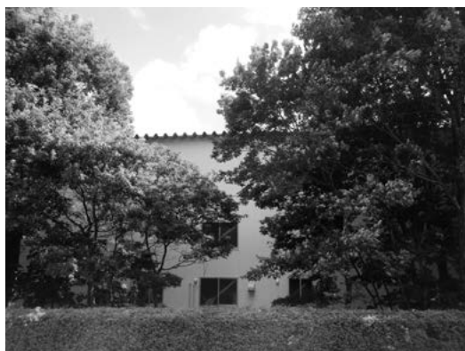
写真4 北側グリーンベルトと軒樋無し屋根
