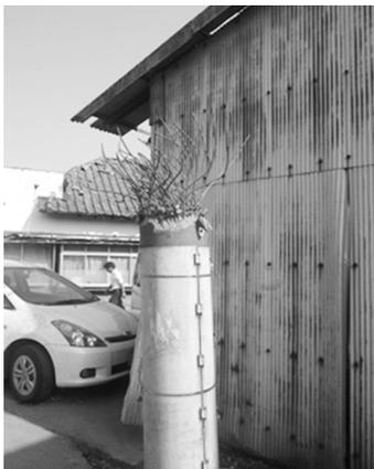
写真4 電柱の破壊状況
