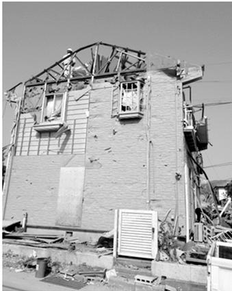
写真2 鉄骨系住宅の被害
