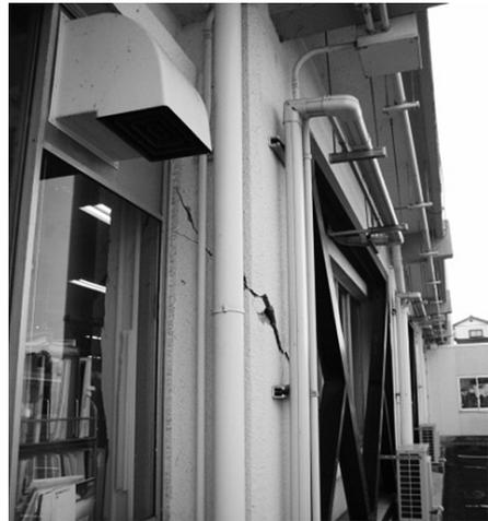
写真2 補強プレース架構の柱のねじりせん断破壊
