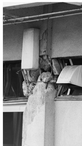
写真1 柱のせん断破壊
