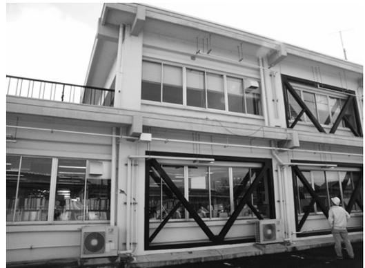
写真3 耐震補強された被災建物
