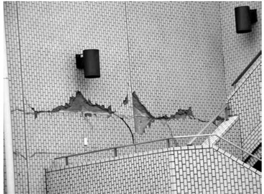
写真13 目地部のタイル剥落
