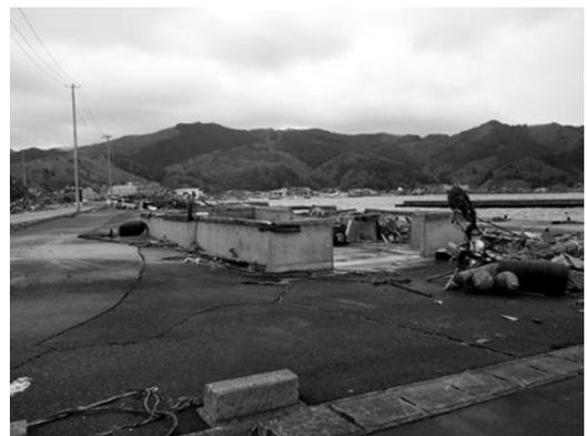
写真6 基礎と土台を残して流失した建物
