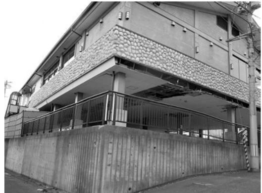
写真17 ピロティ下の軒天井被害
