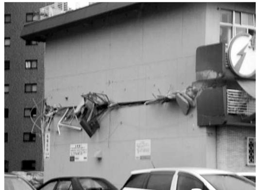
写真10 中間階が層崩壊している
