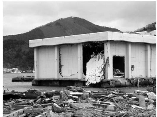
写真4 津波により破壊したRC壁
