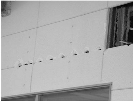
写真15 野縁受によるALCパネルの損傷
