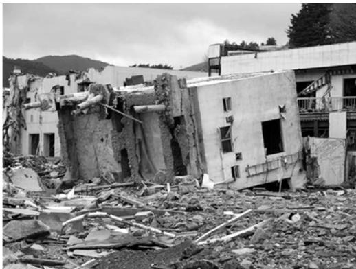
写真3 杭ごと転倒したRC造建物
