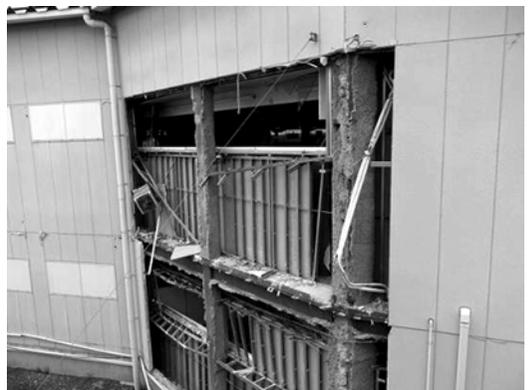
写真14 縦壁挿入筋構法のALCパネル脱落
