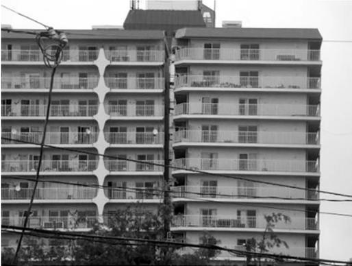
写真11 傾斜したSRC造集合住宅
