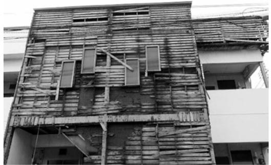
写真12 ラスモルタルの剥落
