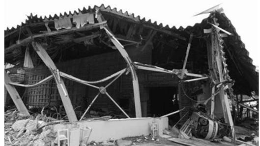
写真5 津波により破壊した低層S造建物
