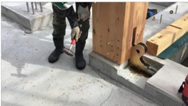
写真9 斜材耐力壁柱脚
