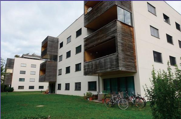
このようなものも建っています。構造の木材の外に不燃のボードを貼っているところが主な部分ですが、バルコニーのところは木でやっているということです。鉄筋コンクリートが1920年頃にできて、日本ではそれで集合住宅を建て始めたということで、その鉄筋コンクリートのうまさを使っているのが、バルコニーだと思います。すなわち鉄筋コンクリートで、スラブをカンチレバーで出すことができる。それによって割に広めのバルコニーを取ることができるようになったのです。
