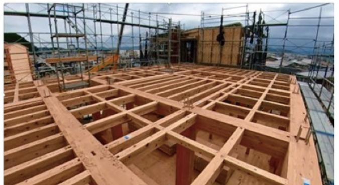
写真12 最上階水平構面
