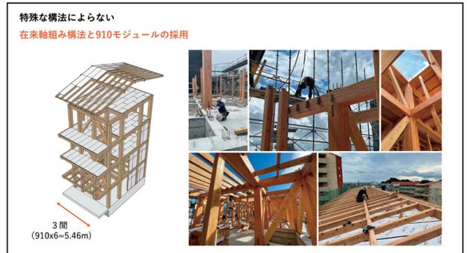
図2 在来軸組構法と910モジュール
