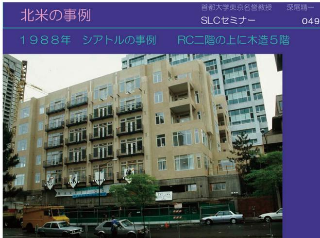
この写真は、シアトルの例で、鉄筋コンクリート2階の上に、木造枠組壁工法で5階の集合住宅を載せるという、当時工事中だったものです。
