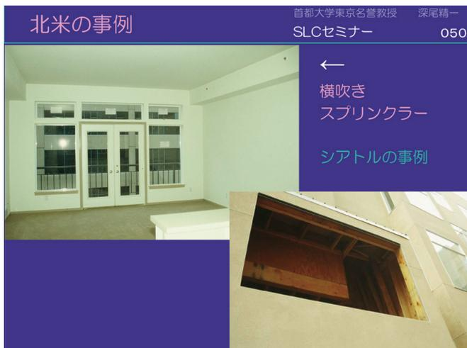
この事例で勉強になったのは、スプリンクラーの設置方法でした。5階分の木造にするために、スプリンクラーが付いているのです。それが横吹きのスプリンクラーで、そこが梁型のように見えたのです。枠組壁工法なのに、なんで梁型が、と思いました。日本のマンションみたいではないかと。当然、構造の梁形ではないのです。その中にスプリンクラーの配管が通っているのです。
