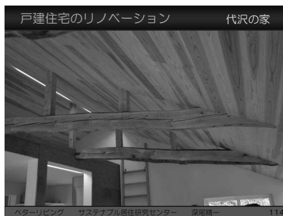
図 26 代沢の家 2F リビング天井
