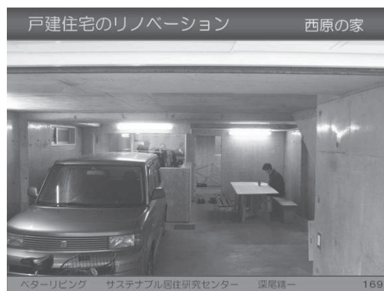
図 35 西原の家 地階車庫
