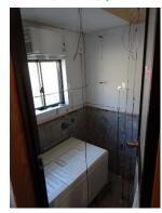
写真2 事前改修前後の浴室 (左:撤去前既存UB、右:撤去後在来浴室)
