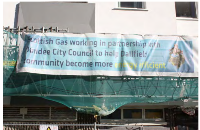
写真1 改修中の高層アパートの横断幕（CESPをアピール）
