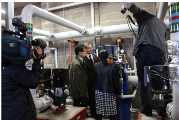
写真3 熱源プラント視察と取材風景
