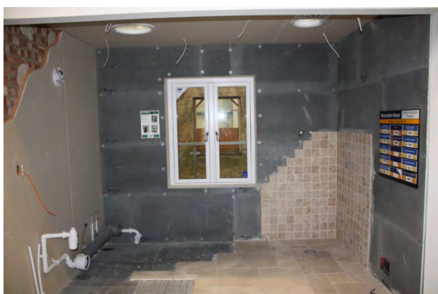
写真7 改修中の浴室
