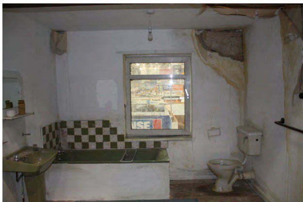
写真6 改修前の浴室
