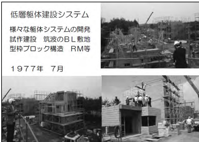
図 13 低層躯体建設システム
